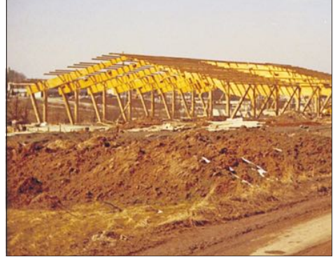
Reithalle im Rohbau 1969
